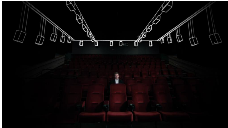
Colocación de los altavoces laterales y superiores en una instalación Dolby Atmos. Fuente: Dolby
