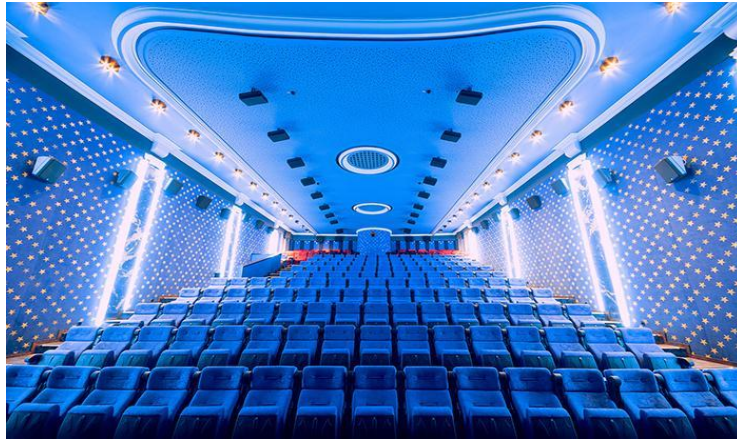
Colocación de los altavoces en un sistema multicanal de sonido envolvente para una sala de exhibición de cine. Fuente: wikipedia
